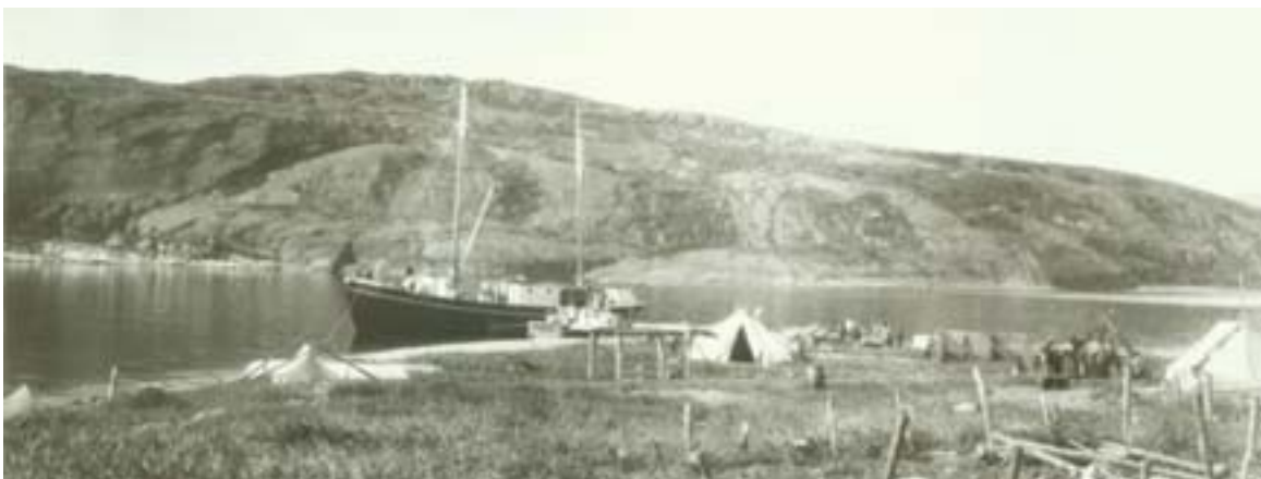
Figure 11 : Poste de traite de Revillon Frères sur l'île Qikirtaaluk en 1927 (île Cairn, site HaGb-11), photo PA 96699, Archives publiques du Canada, collection Indian and Northern Affairs, auteur : L. T. Burwash.
