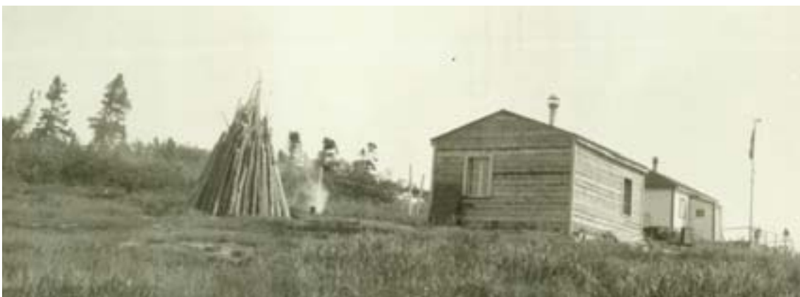
Figure 9 : Poste de traite de Revillon Frères sur l'île Qikirtaaluk en 1927 (île Cairn, site HaGb-11), photo PA 103934, Archives publiques du Canada, collection Indian and Northern Affairs, auteur : L. T. Burwash.
