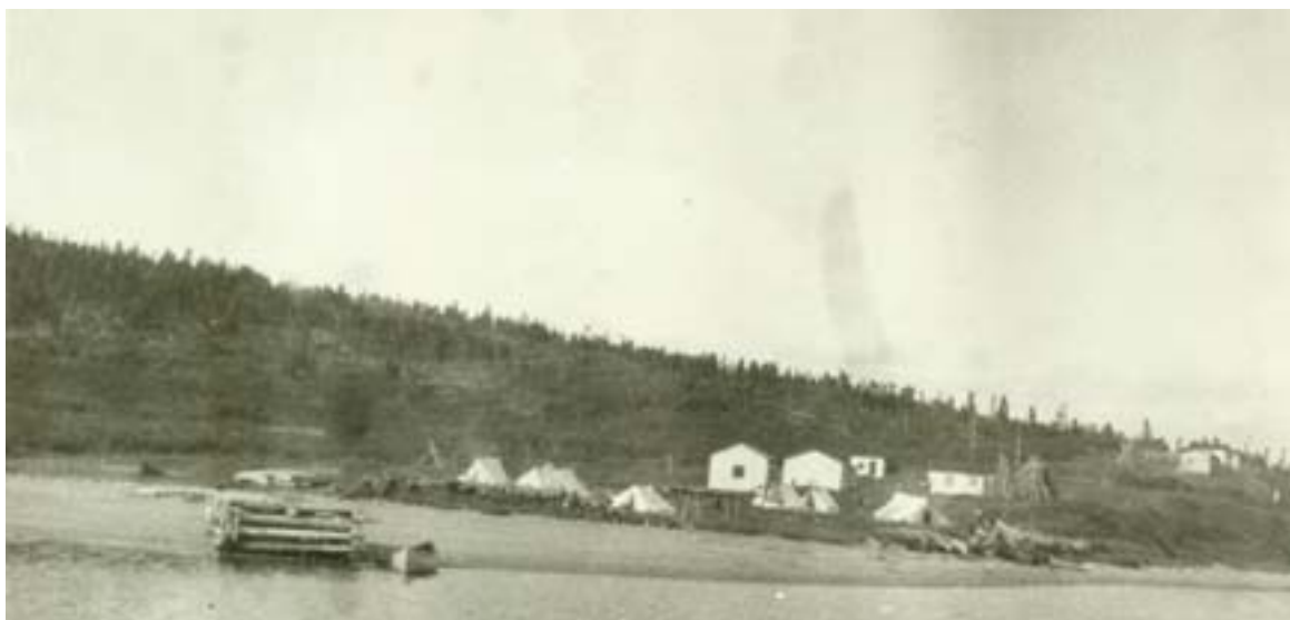
Figure 6 : Poste de traite de Revillon Frères sur l'île Qikirtaaluk en 1927 (île Cairn, site HaGb-11), photo PA 103939, Archives publiques du Canada, collection Indian and Northern Affairs, auteur : L. T. Burwash.
