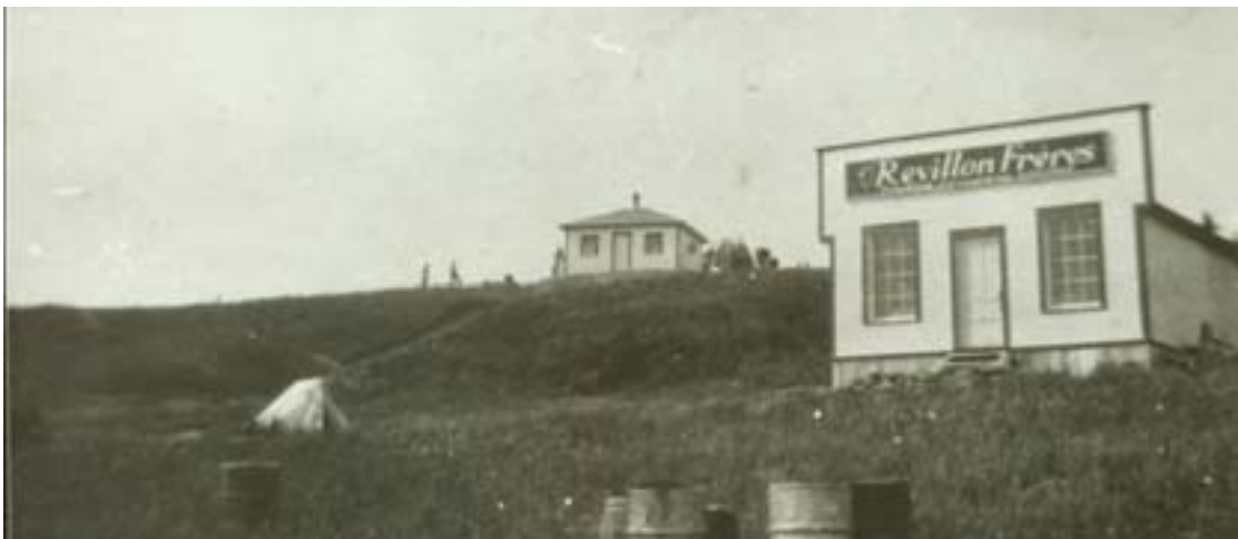
Figure 7 : Poste de traite de Revillon Frères sur l'île Qikirtaaluk (île Cairn, site HaGb-11), Archives Revillon Frères Pell.29, photo 26, no. inventaire 1441.
