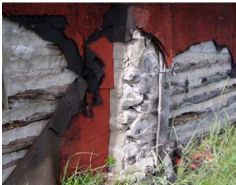
Figure SA043 : Détails de la structure de la maison 6, en billot de bois recouvert de béton et de bardeau d'asphalte, site George Papps (HaGa-1, UMI-83).
