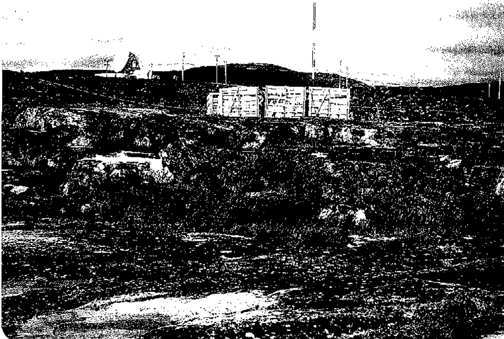
Photo 28. Site IcGm-8, construction du bâtiment de la Société Makivik.
